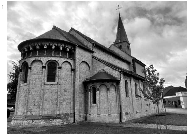
Fig. 1. Sint-Pieterkerk van Sint-Truiden, waar de grafsteen zich momenteel bevindt. De kerk zelf is quasi volledig opgebouwd uit gele Tufsteen van Lincet (foto R. Dreesen).
